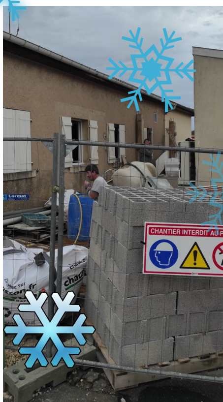
La salle Maurice Bouchot en travaux pour plusieurs mois
