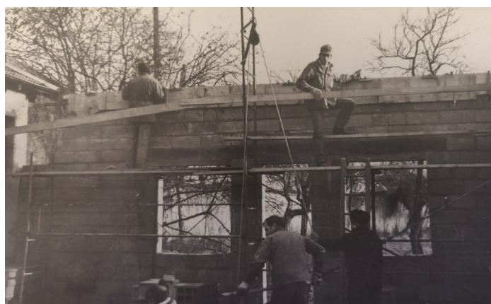
Des photos de la construction de la salle M. Bouchot étaient visibles durant le repas
