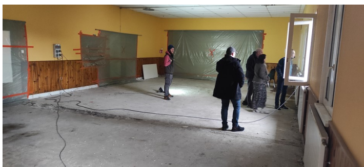
Les travaux sont lancés après la dépose du parquet
