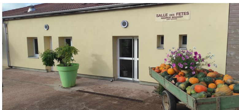
Inauguration de la salle des fêtes Maurice Bouchot rénovée
