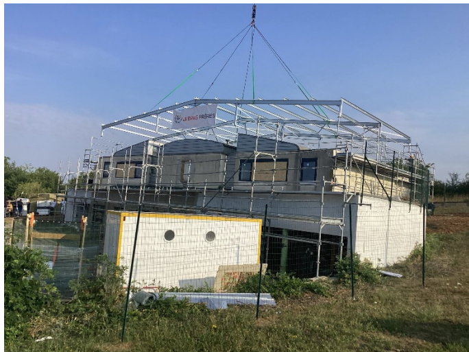
... pour l'installation de la nouvelle charpente
