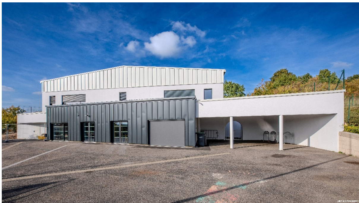
Le défi du chantier de rénovation pour l'école élémentaire du Mont Hachey
