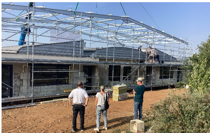
Suivi des travaux depuis l'arrière de l'école
