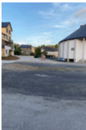
Abords du Pôle culturel un premier terrassement a été effectué en attendant les travaux d'aménagement plus conséquents.
