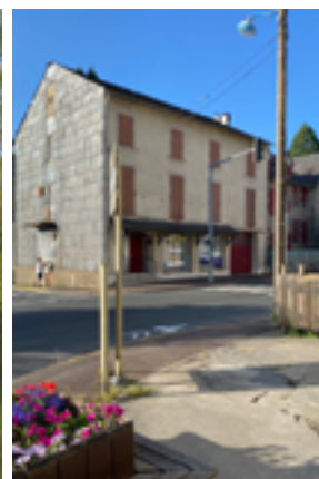
Maison Rul réfection de l'intégralité de la toiture cet été.
