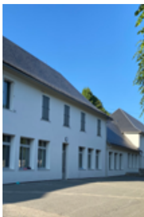
Ecole primaire rénovation achevée (toiture, chauffage, huisseries, volets, isolation...).
