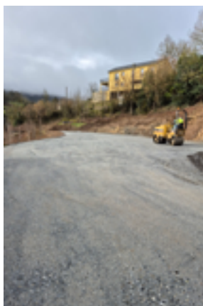
Bâtiment H. Antoine le terrassement des abords a terminé les travaux. Nos Services Techniques sont installés.
