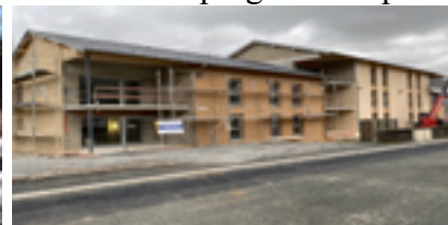
▲ Etat des travaux (Novembre 2024)
