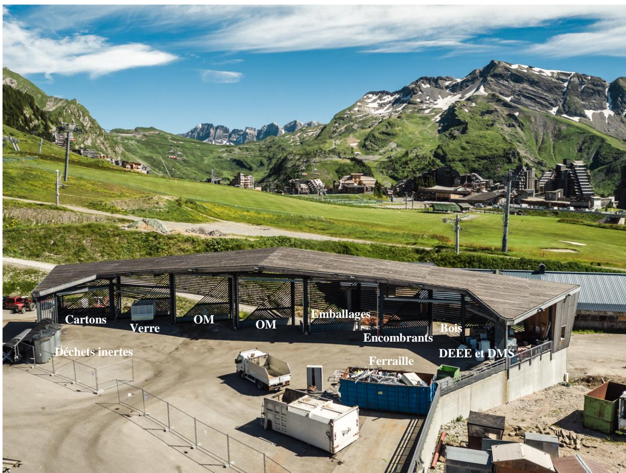
Photo 6 : vue aérienne de la déchèterie d'Avoriaz
