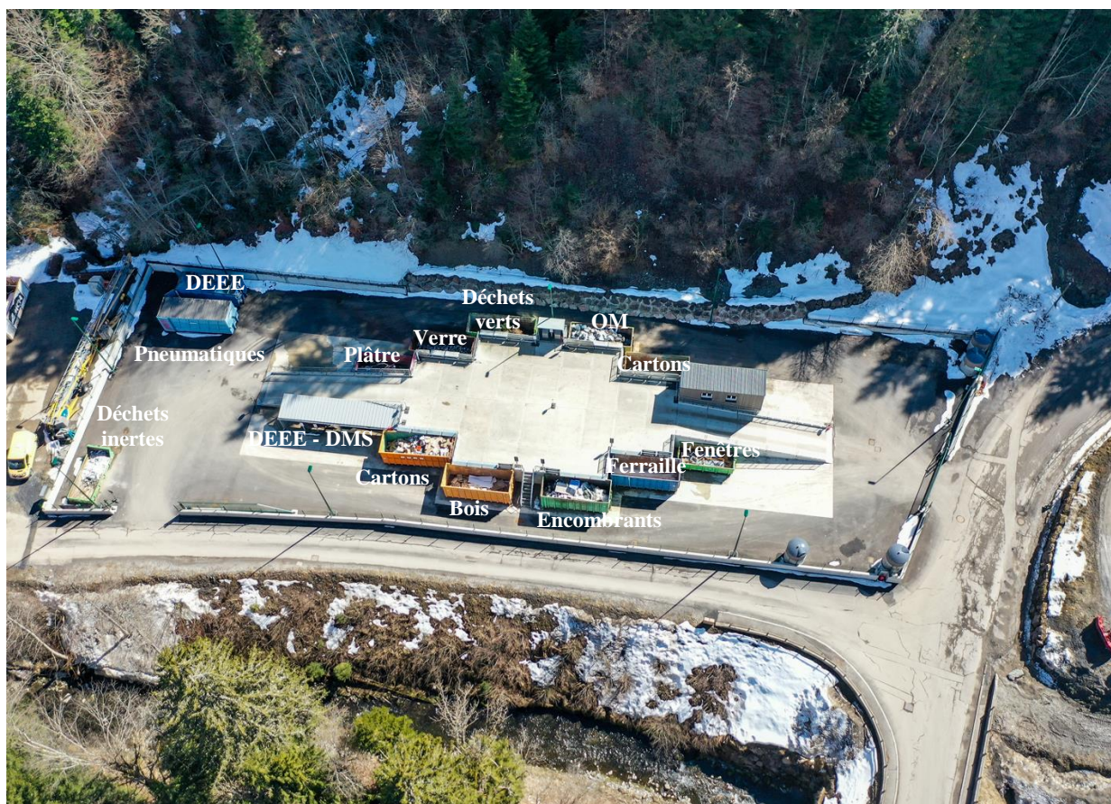
Photo 7 : vue aérienne de la déchèterie des Gets
