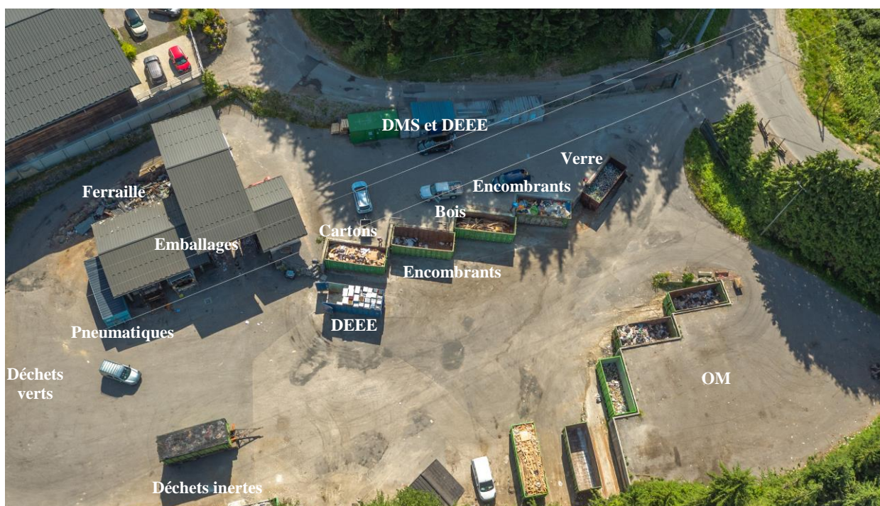
Photo 5 : vue aérienne de la déchèterie de Morzine
