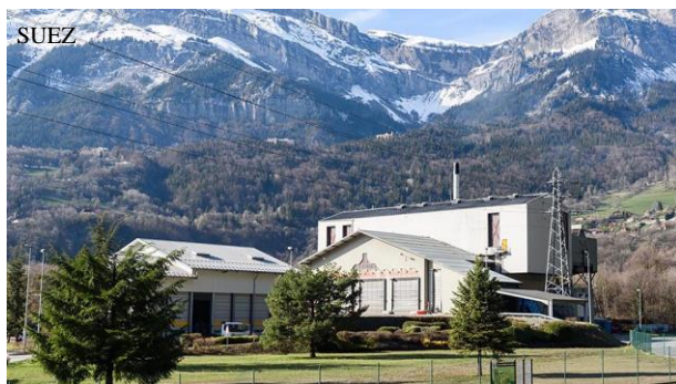
Photo 2 : usine d'incinération de Passy
