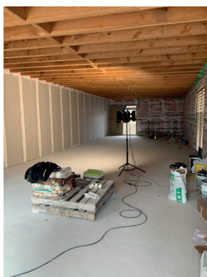
Cellule Réserve Utile
