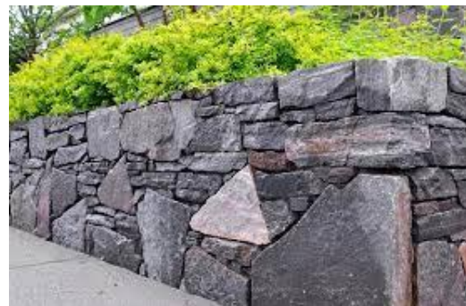
Enrochements en blocs de pierres rappelant l'esprit des murs.
