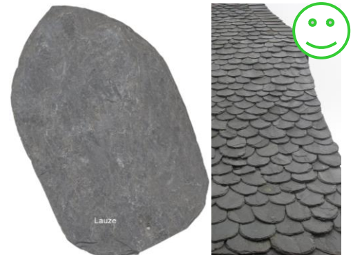
Toitures en lauzes et en ardoises naturelles autorisées
