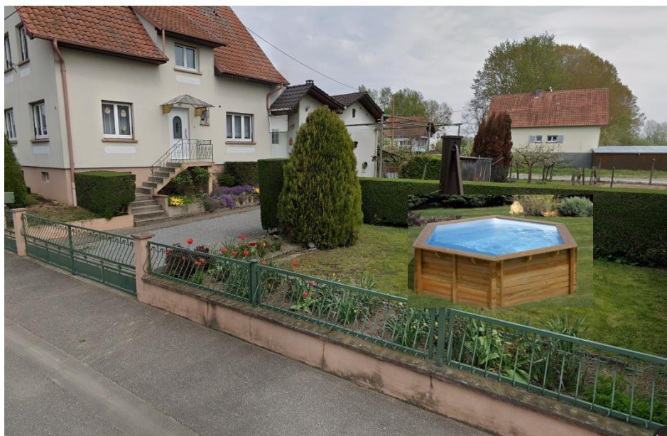
Installation d'une piscine
