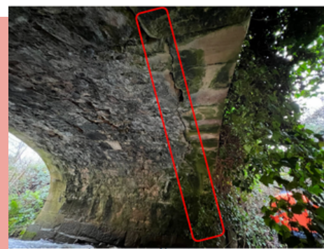
Figure 2 - Vue d'ensemble du démontage du bandeau du côté amont de l'ouvrage
