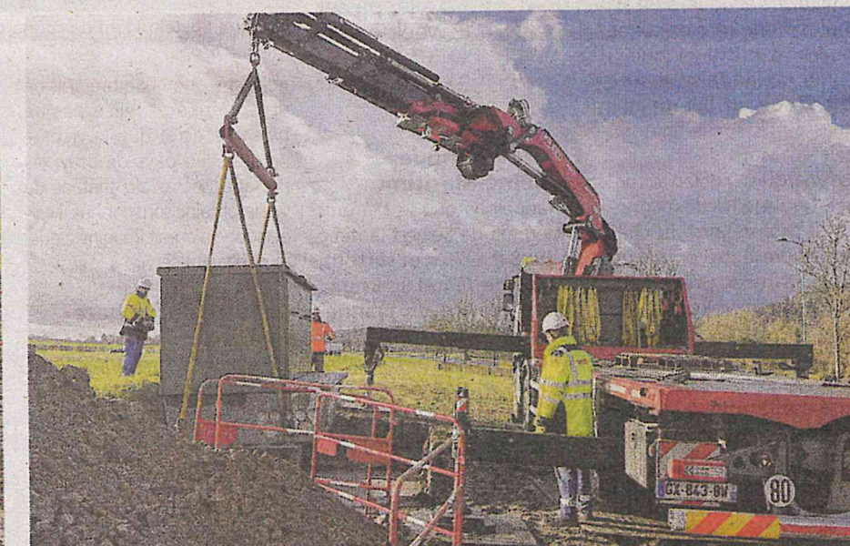
Opération réussie : le poste d'alimentation électrique a bien été posé dans son emplacement. L'Eclairer-La Dépêche
