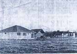
La habitation des Chénouans - cinq villas (et bientôt une sixième) construites sur une parcelle appartenant pour 1 tiers à la commune de Marcellaz, et deux tiers à ses voisins Polleymont, deux communes de la vallée de l'Arve.
