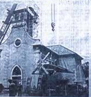
Soutenue par une puissante grue, la charpente du clocher a été installée le 21 octobre. Une toiture en cuivre la recouvrira bientôt.
