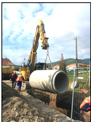
Septembre Travaux en vue de l'évacuation des eaux pluviales des rues des Oiseaux et de la Cote 425
