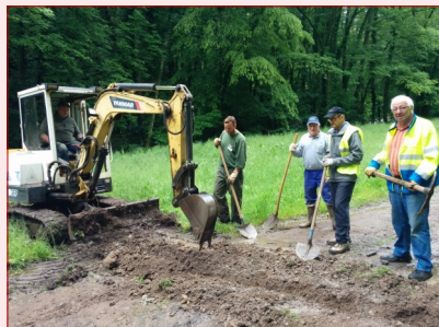
Pose de bois d'eau en forêt
