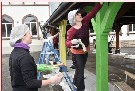
Peinture des poteaux du préau de l'école
