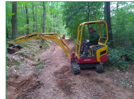
Curage et réfection de fossés
