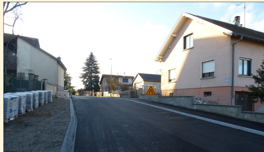
Pendant : les travaux touchent à leur fin
