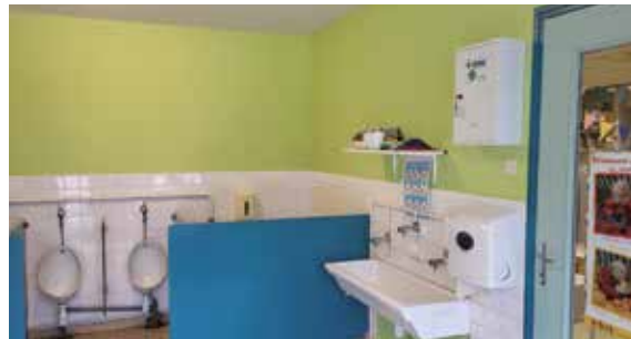
Sanitaires des Grands Chênes avant les travaux
