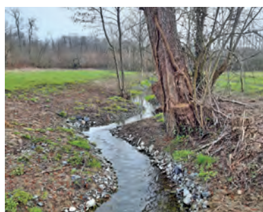
2 - Recharge granulométrique sous forme de banquette - Exemple de mise en œuvre (SMBVAR)
