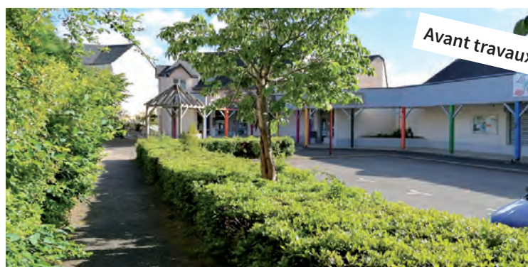
La Place des Jardinets avant les travaux
