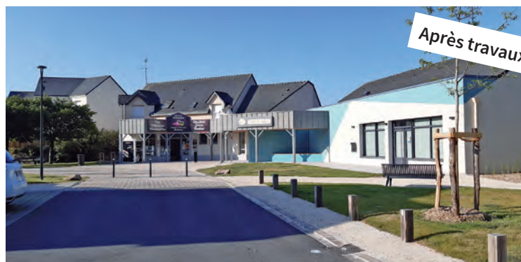
La Place des Jardinets à Saint-Léger-des-Bois réaménagée
