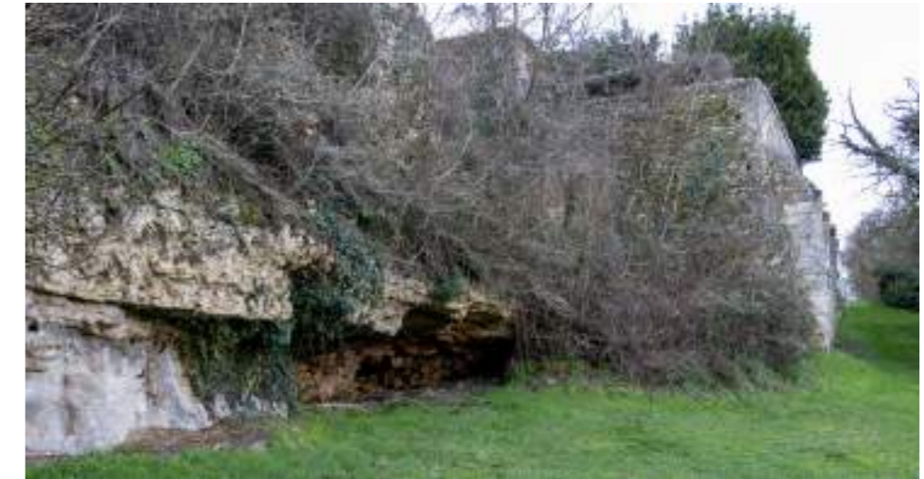
Homps, escarpement rocheux, accueillant la base des remparts
