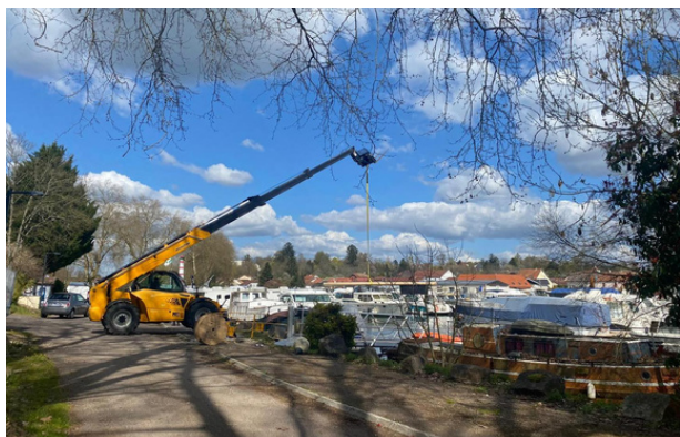
Changement des pontons défectueux
