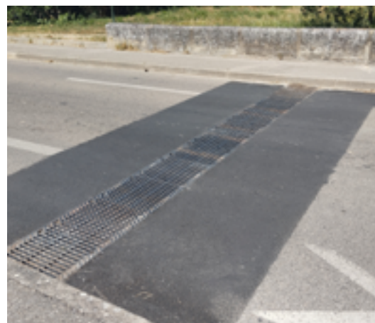
Mise en place d'un caniveau grille sur la commune d'Eyragues
