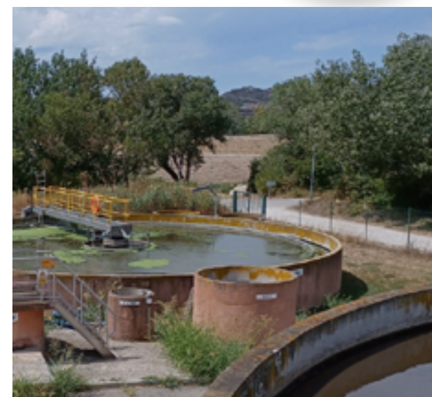
Station d'épuration à Barbentane
