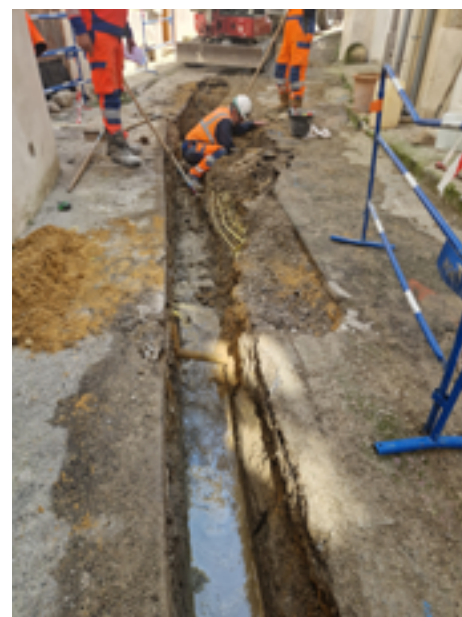
Travaux dans l'Impasse de l'Eglise
