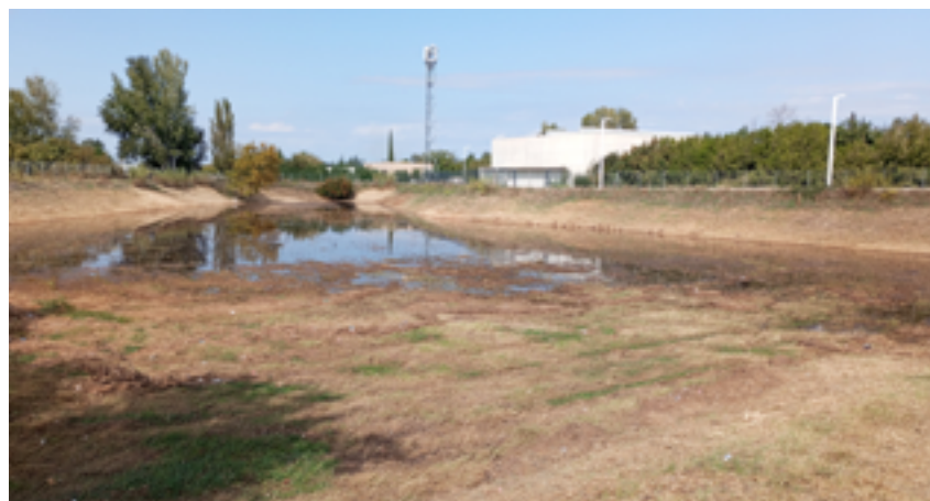
Bassin de rétention après entretien - Châteaurenard
