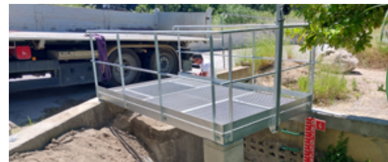
Travaux de la vanne - Pont de Rognonas
