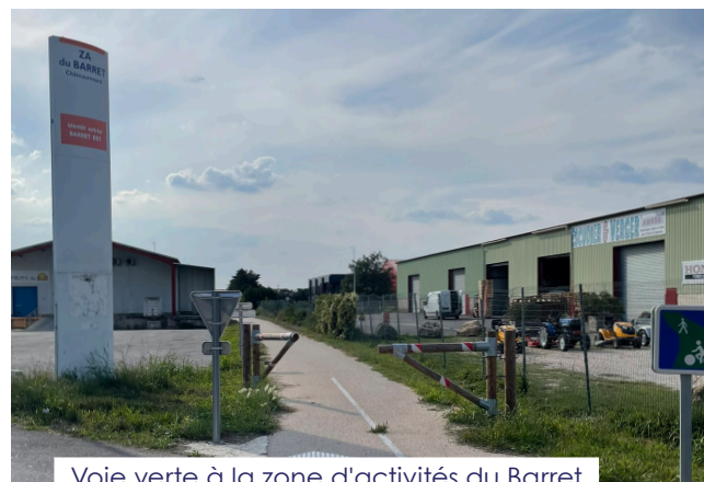
Voie verte à la zone d'activités du Barret
