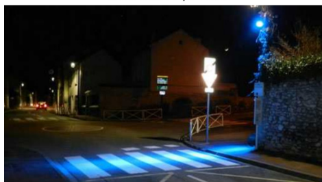
Traversée lumineuse / © CEREMA
