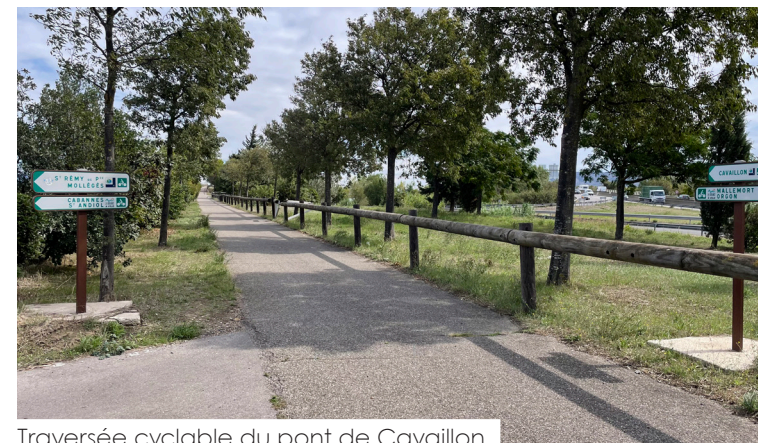
Traversée cyclable du pont de Cavaillon
