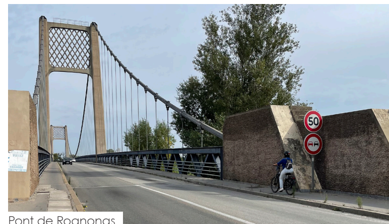
Pont de Rognonas
