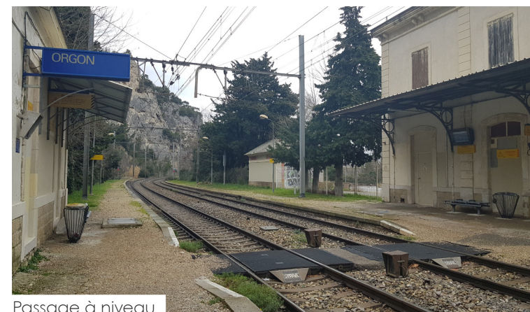
Passage à niveau
