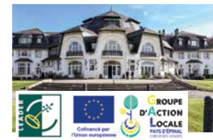
Lancement d'un audit patrimonial à La Rotonde à Thaon-les-Vosges - octobre
