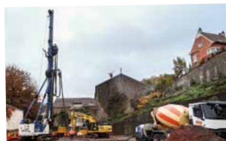
Démarrage de la construction du nouvel auditorium de La Louvière à Épinal - avril
