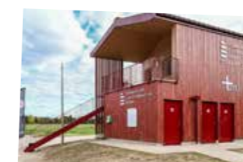
Construction d'un poste de secours au domaine des Lacs à Thaon-les-Vosges - octobre
