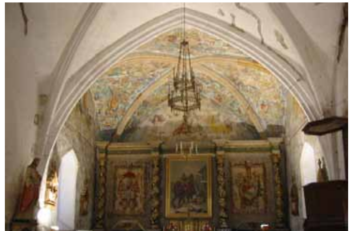
Vue d'ensemble des voûtes peintes du coeur. Le décor foisonnant de rinceaux d'acanthes s'accorde avec le rétable de style baroque du maître autel. CD Lot
