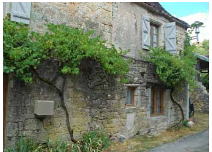
Treilles de vigne courant sur une façade à Saint-Martin-de-Vers.
