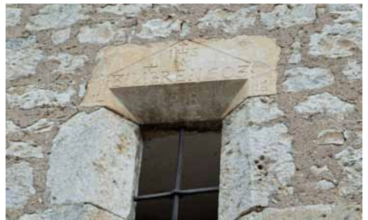
Le linteau de la fenêtre percée dans le mur sud du chœur porte la date de 1603.
