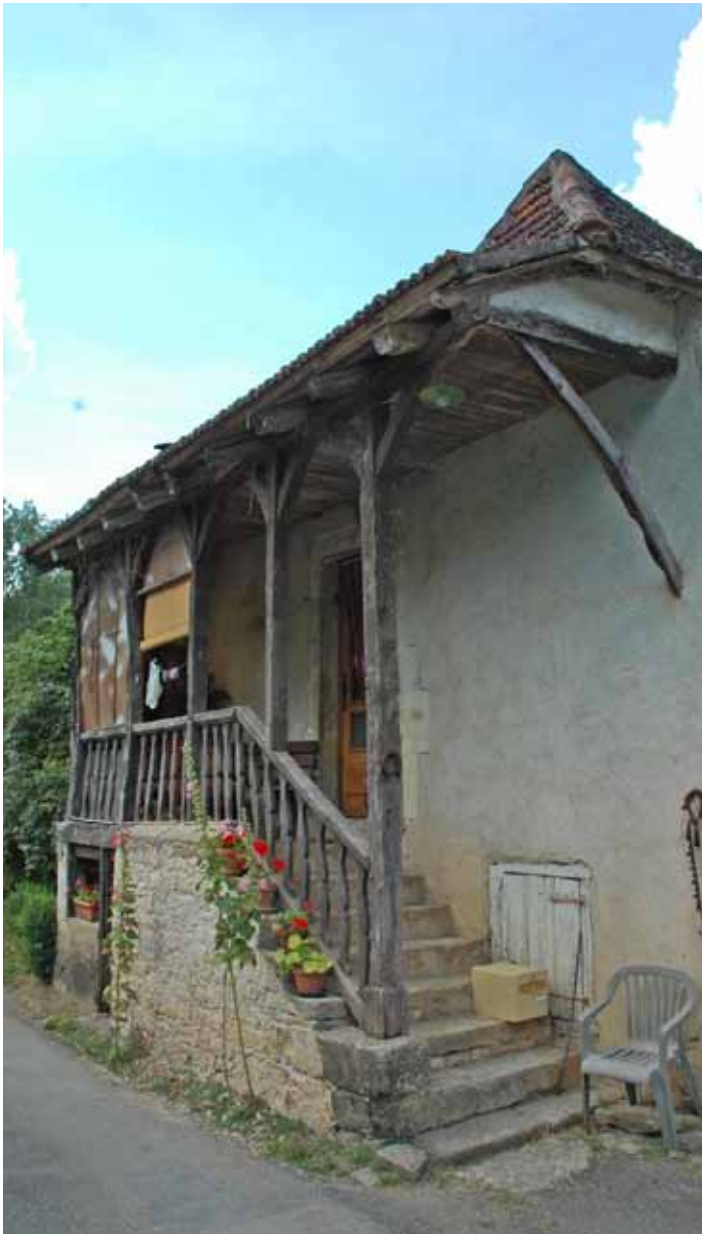
Bolet couvert d'un auvent en charpente dans le village de Saint-Martin. L'ouvrage repose sur des piliers en bois et est doté d'un garde-corps en bois.
