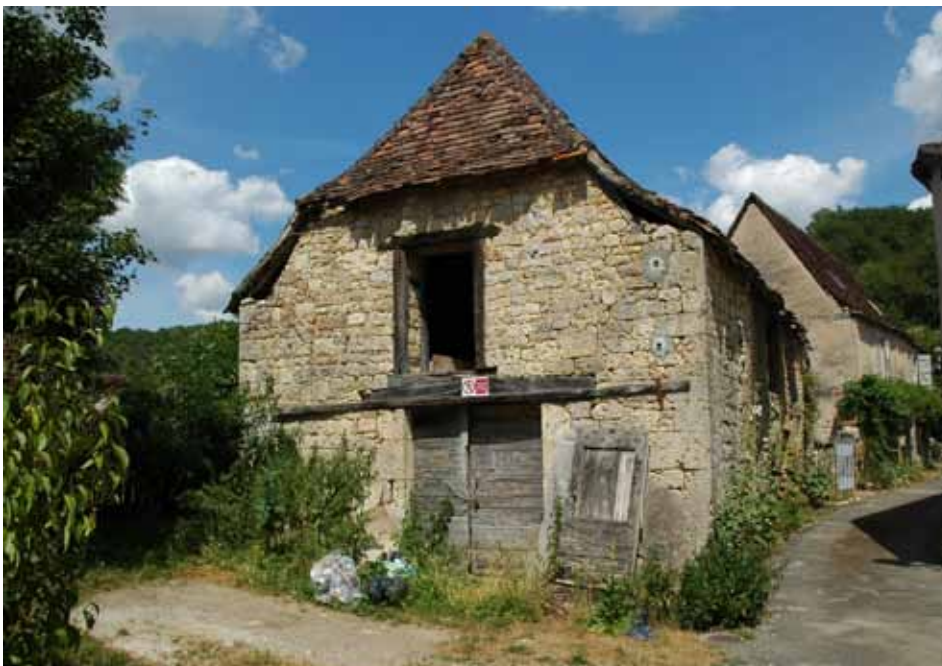
Grange-étable ouvrant sur un espace connexe à l'espace public dans le bourg de Saint-Martin-de-Vers.
