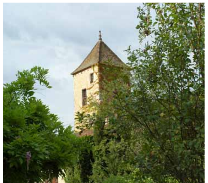
Tour de la maison dite "château de l'abbé" de Saint-Martin-de-Vers.
