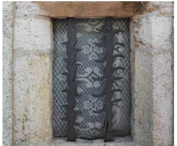
Jour doté de ferronneries défensives dites "estripe-loups" à Saint-Martin-de-Vers.
