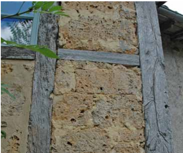
Remplissage d'un pan de bois en moellons réguliers de tuf à Saint-Martin-de-Vers.
