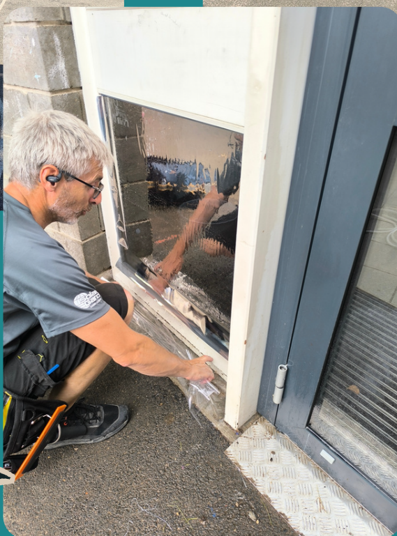
Pose de films sur les vitres de l'école avec 2 fonctions :
