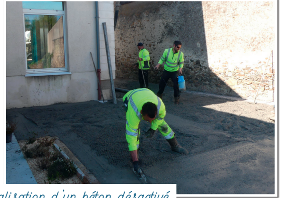
Réalisation d'un béton désactivé
