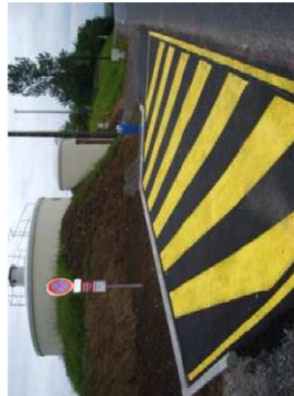
Plate forme d'aspiration sur une réserve d'eau équipée d'un poteau d'aspiration de 100 mm
