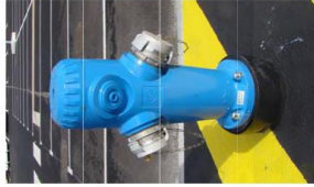
Poteau d'aspiration à réseau sec de 150 mm, muni de deux sorties de 100 mm et d'un Airclap. Pas de carré ni de volant de manoeuvre
