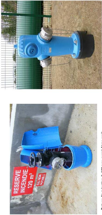
Poteau d'aspiration de 100 mm, muni d'une seule sortie de 100 mm et d'un volant de manoeuvre
