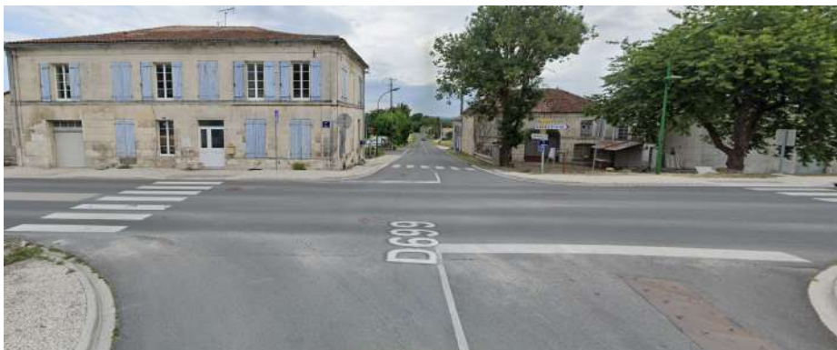
Croisement entre la RD699 et la RD731 - La Grue
