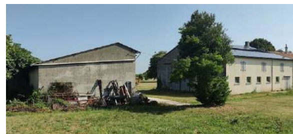
A gauche hangar de la parcelle n° 382, façade nord
