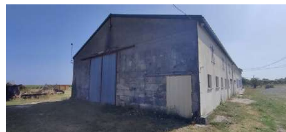
Hangar de la parcelle n° 382, façade ouest
