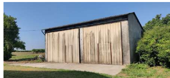
Hangar de la parcelle n° 380 façade est et nord
