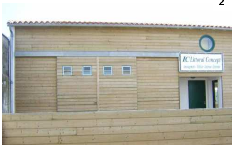
Bâtiment d'activité en bois
