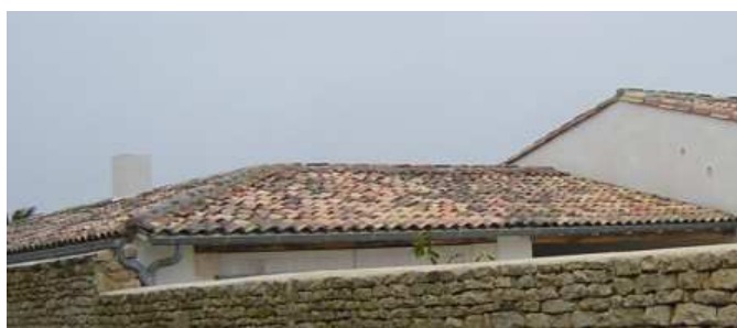
Toiture à tuiles « canal » de teintes mélangées
