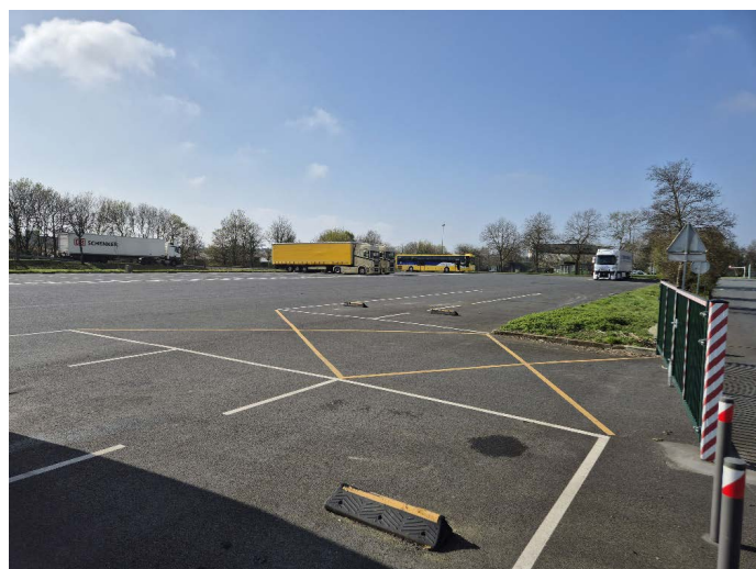
Réfection du parking poids lourds du Foirail (Cholet)
