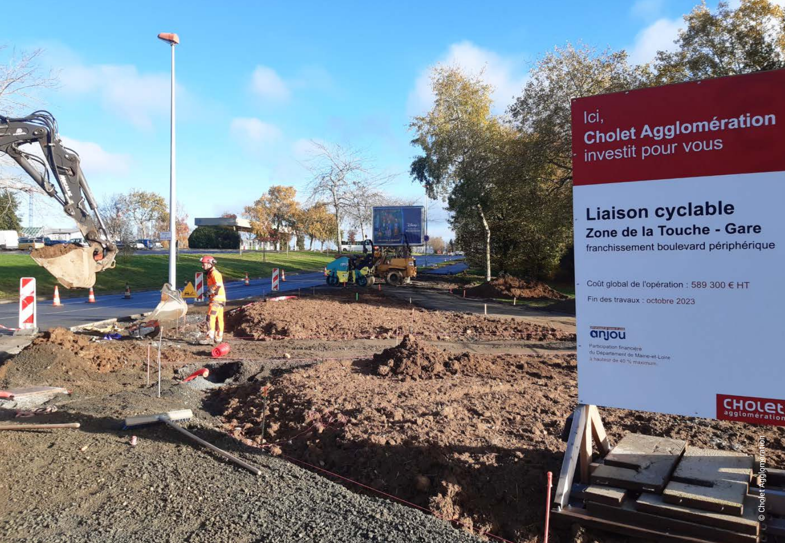
Travaux liaison cyclable avec Thales
