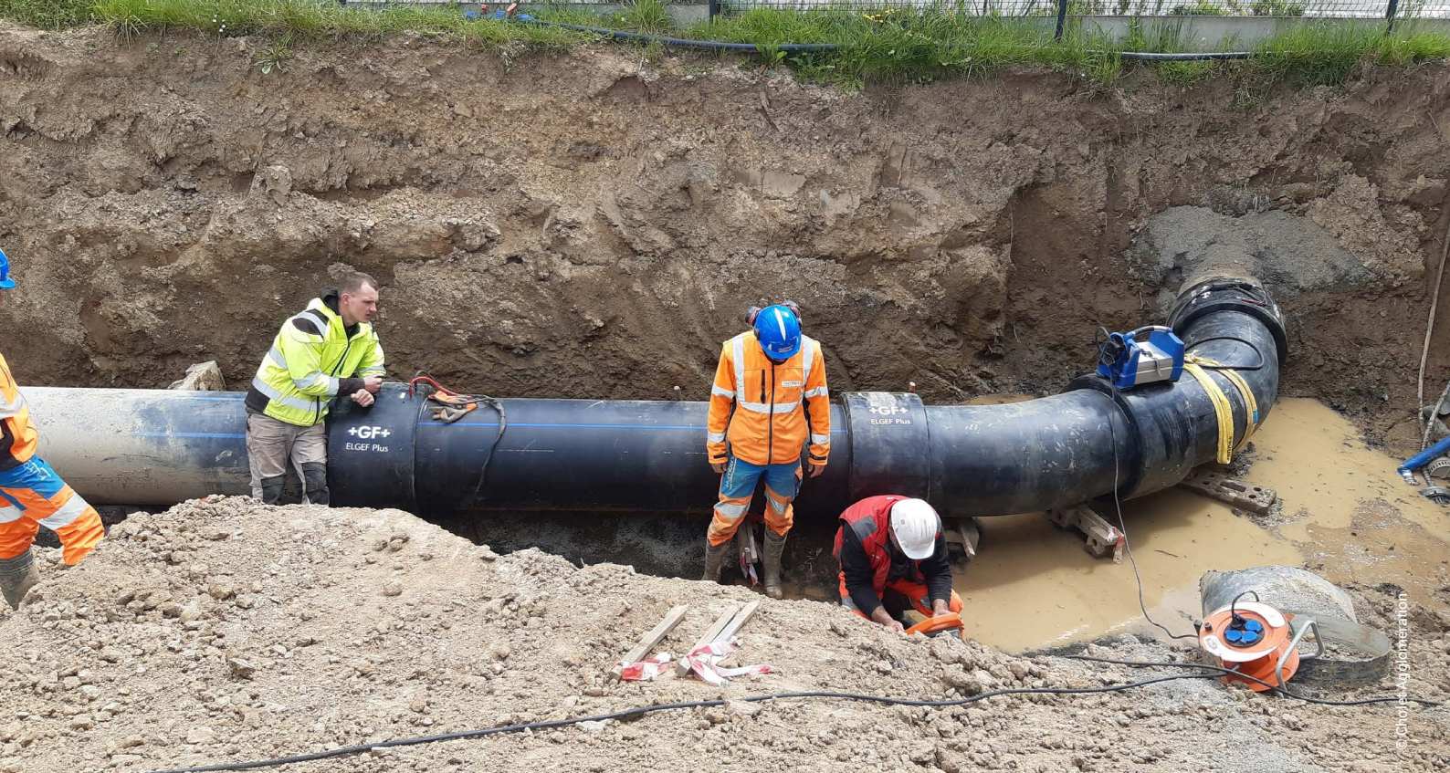
Déplacement de la conduite de transport d'eau potable diamètre 630 mm ZAC Val de Moine (Cholet)
