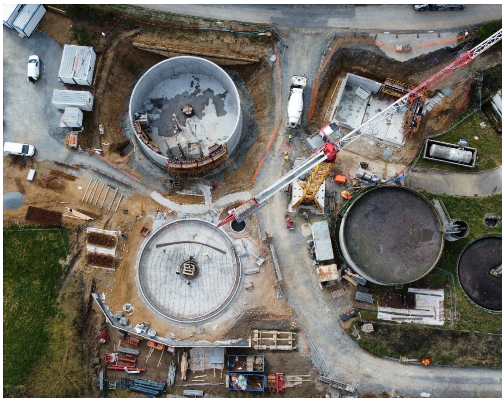
Travaux de la nouvelle station d'épuration de Maulévrier
