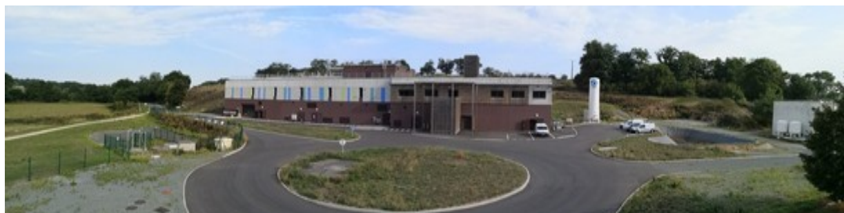
Bloc de traitement T4 de l'usine de Ribou (2019)
