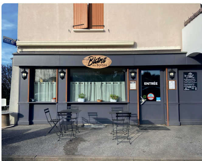
Ravalement de la façade du Bistrot
