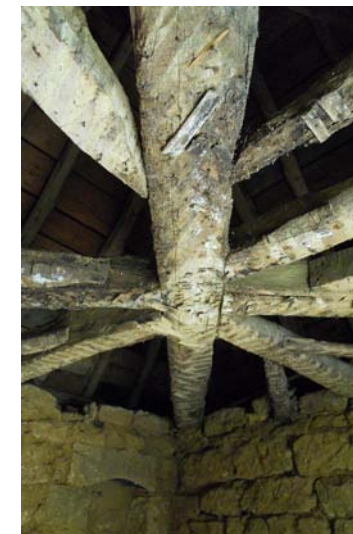
Détail de la charpente.
