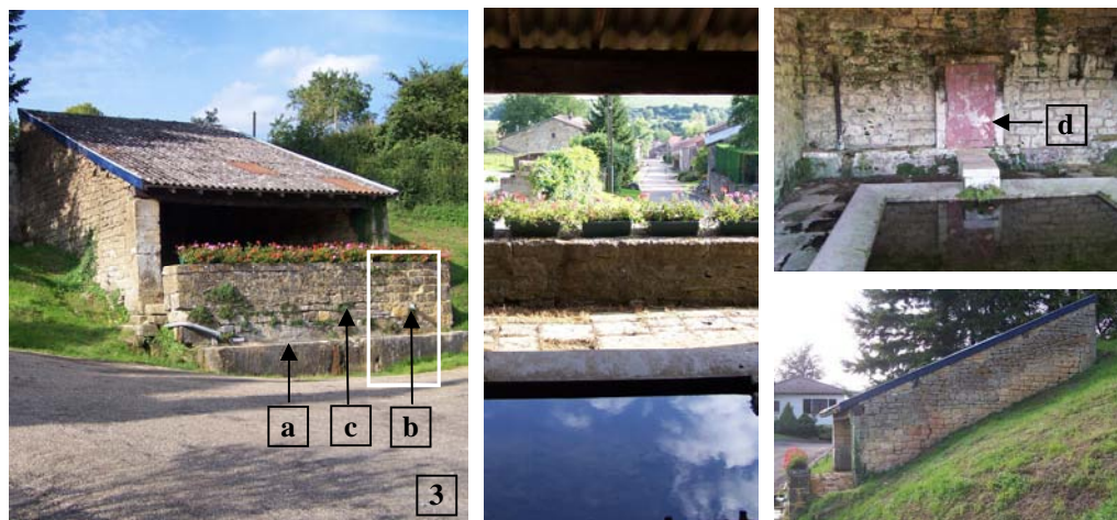
Dénomination : Lavoir et fontaine-abreuvoir, rue Haute Fontaine
