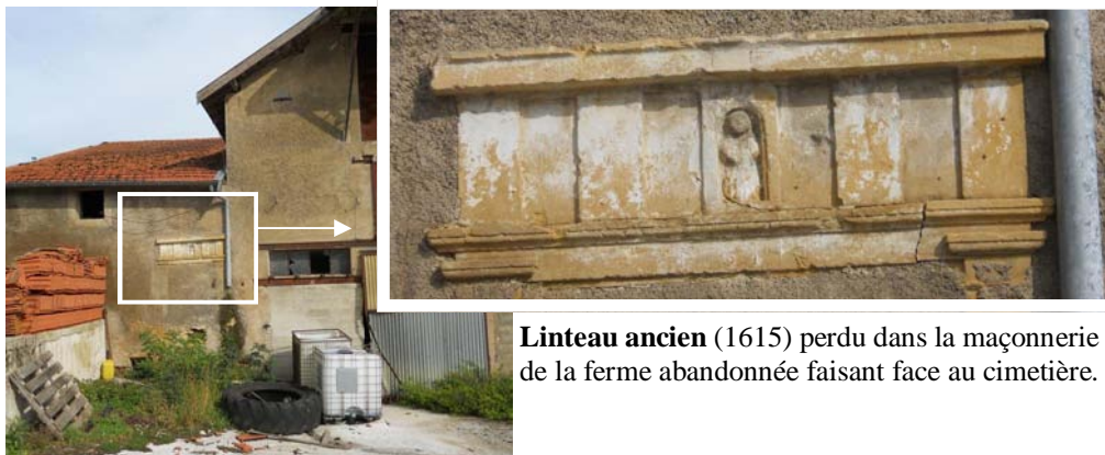
Un bétonnage excessif devenu caduc.
