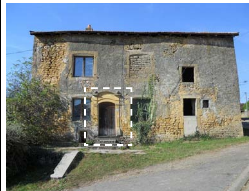
Eléments de façade de caractère
