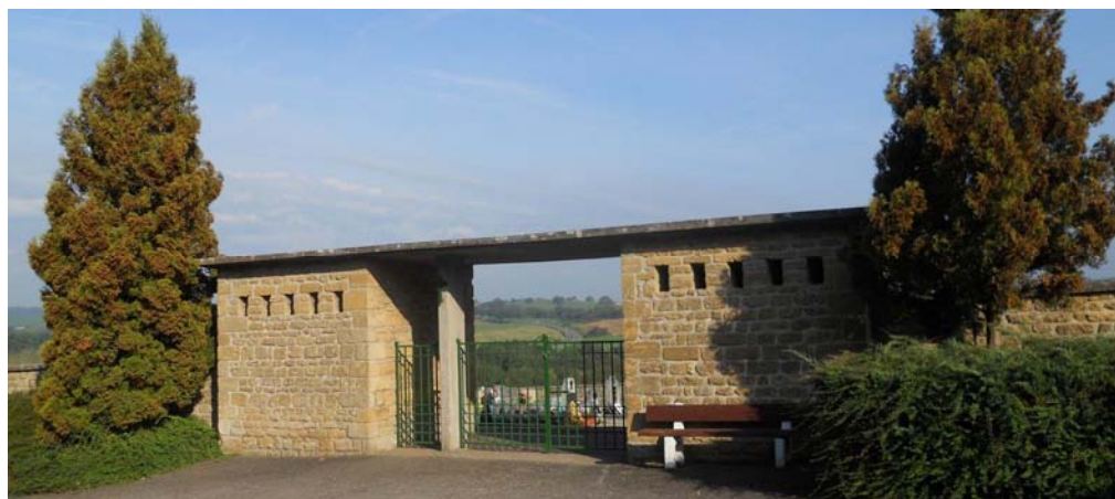
Vue sur l'entrée - Côté route d'Avioth
