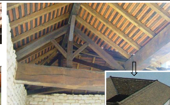
Etat de la couverture et de la charpente, situation actuelle.
