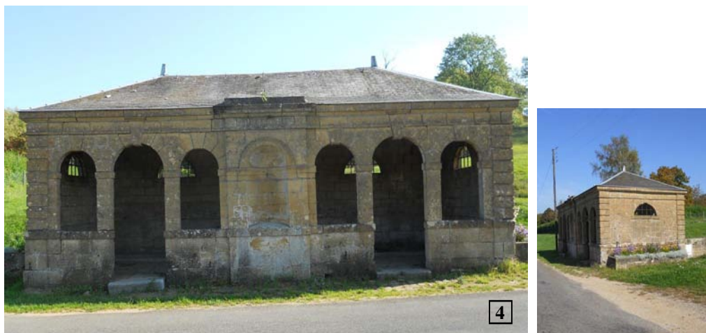
Dénomination : Lavoir, chemin de la ville haute
