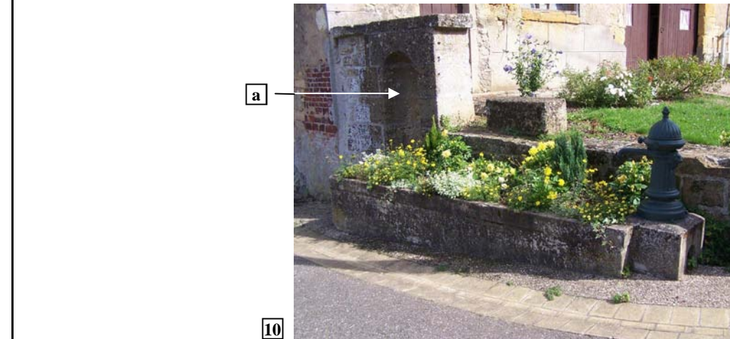
Dénomination : Fontaine-abreuvoir rue des Vignes
