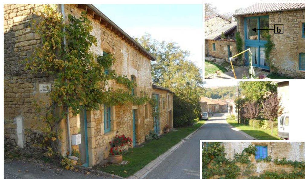
Maison ancienne rue Haute. La touche contemporaine portée sur la façade arrière (b) et la porte piétonne (c) n'altèrent en rien le caractère rural de cette maison paysanne.
