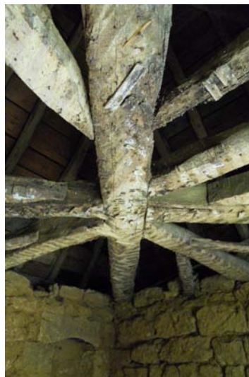
Détail de la charpente.
