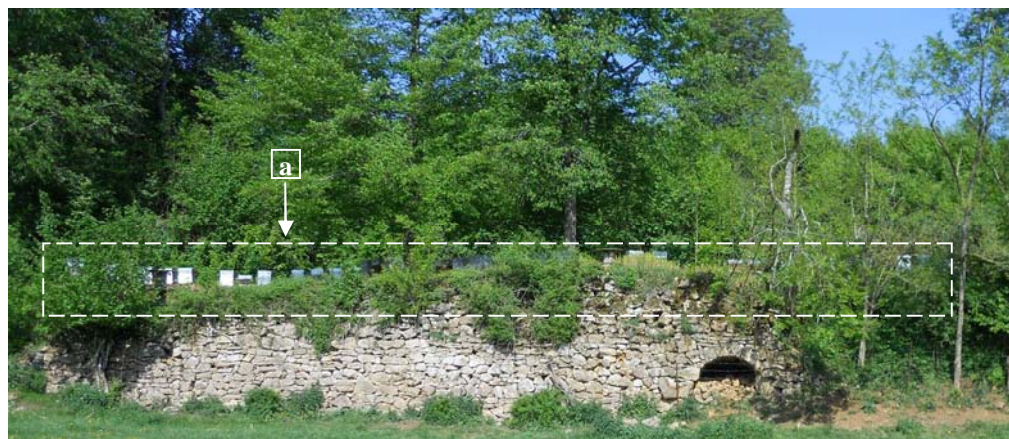
Mur de soutènement en pierre sèche. La structure caverneuse du mur mêlée à un environnement paysagé diversifié fournit un milieu favorable à l'évolution de la faune et de la flore locale. Dans le cas présent, endroit propice à l'implantation de ruches (a).
