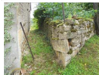
Mur en pierre sèche à l'entrée du chemin menant à la fontaine du Longway.
