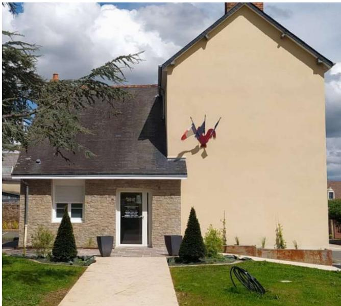
Des élus ont réalisé la réfection de la façade avec la mise en place de parements. Nous sommes en attente du jambage pour l'habillage des portes et fenêtres, l'entreprise choisie pour cette prestation n'ayant pas livré les bons modèles.
