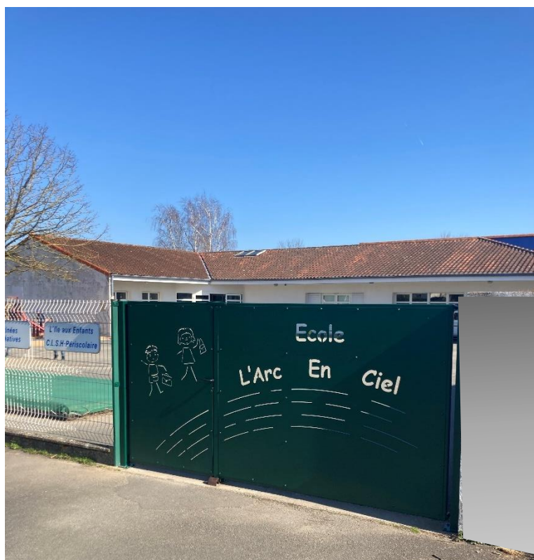
Installation d'un nouveau portail à l'école réalisé par l'entreprise Talon
