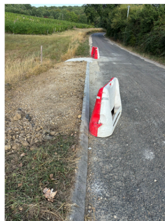
Chantier : pose des bordures.
