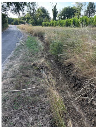
l'entreprise des fossés.
