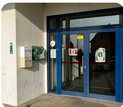
Porte d'entrée du rez-de-chaussée de la Maison des Associations
