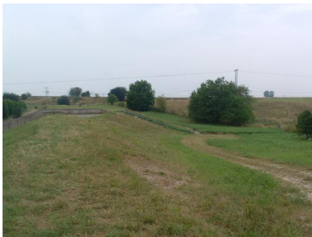
Une des digues de Fontenay
