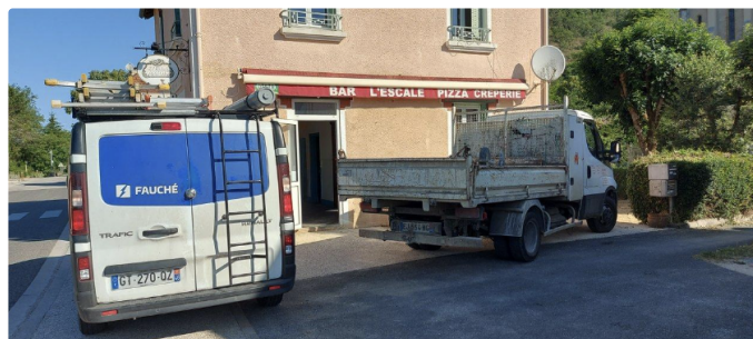
Le chantier de L'Escale a démarré.
