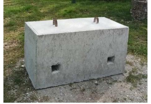
*Ces blocs de bétons protègent certains accès du passage de véhicules*
