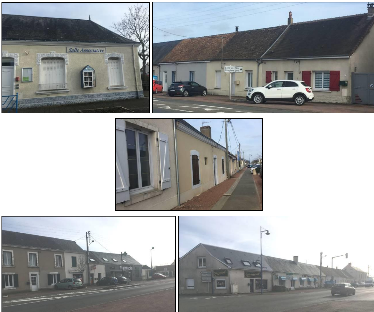
Photographies de bâtisses du centre-bourg.
