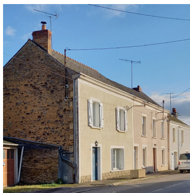
Mur en pierre enduite en façade
