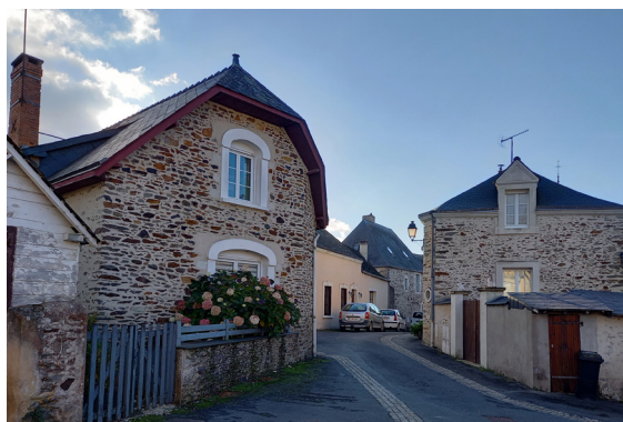
Mur en moellon, pierre de pays non enduite
