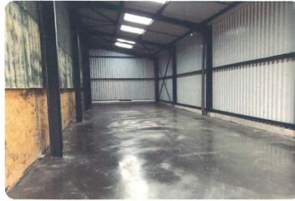
Les travaux de structure, de bardage et de charpente sont achevés. La porte sectionnelle a été posée. La dalle béton finition quartz a été coulée. Après le respect d'un temps de séchage, les 3 éléments de désenfumage seront posés et toute la partie électricité sera réalisée. La partie initiale de l'atelier verra son éclairage remplacé.
