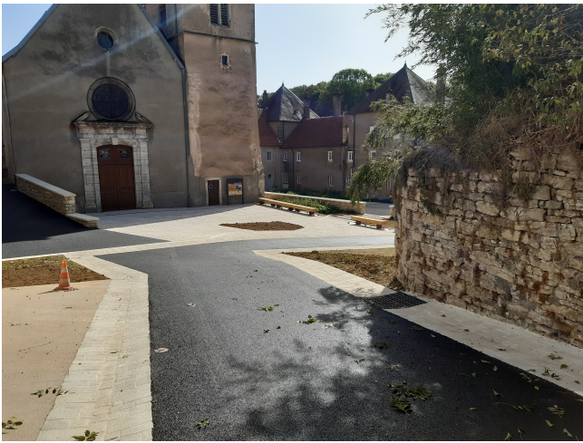
La voie initialement prévue en pavés a finalement été bétonnée en raison de l'importance de la pente
