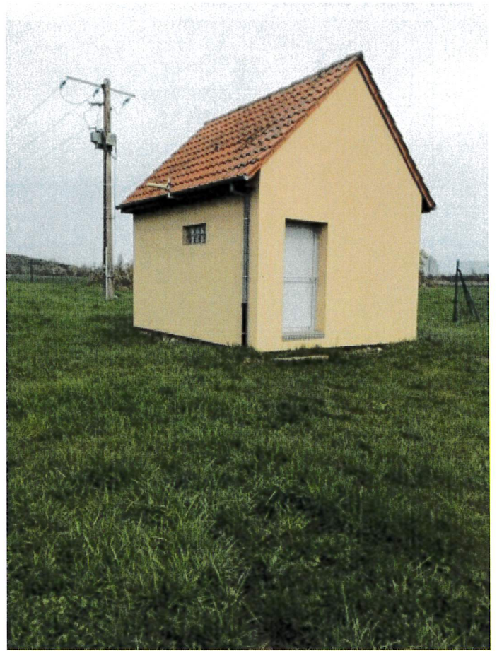
La station de pompage
