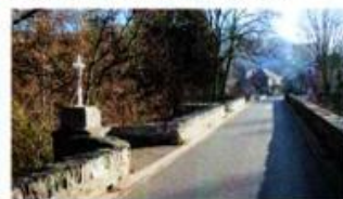
3- Vue depuis le vieux pont du Saillant
