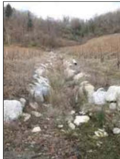
**Figures 11 :** Vue sur les travaux d'enrochements réalisés après la coulée boueuse.
