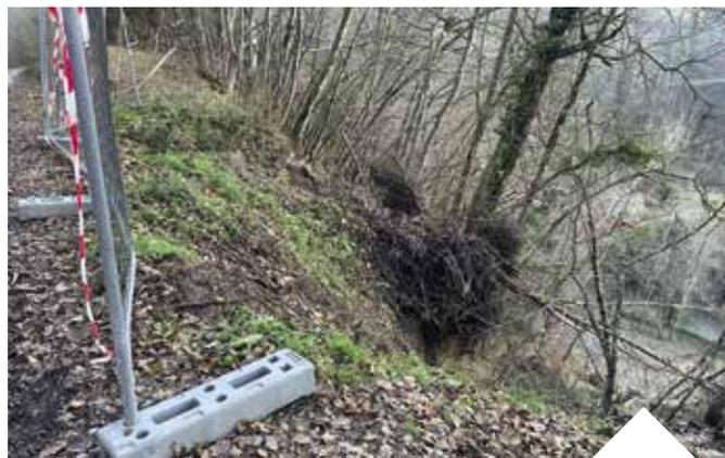
**a mandaté le bureau Kaéna pour un diagnostic géotechnique.** Il s'agit d'établir la cause géotechnique du glissement de terrain en effectuant des sondages et proposer des principes de réparation.
