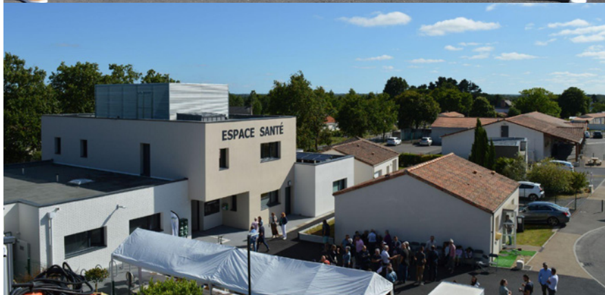
photo aérienne prise depuis une nacelle de l'entreprise Longépé location
