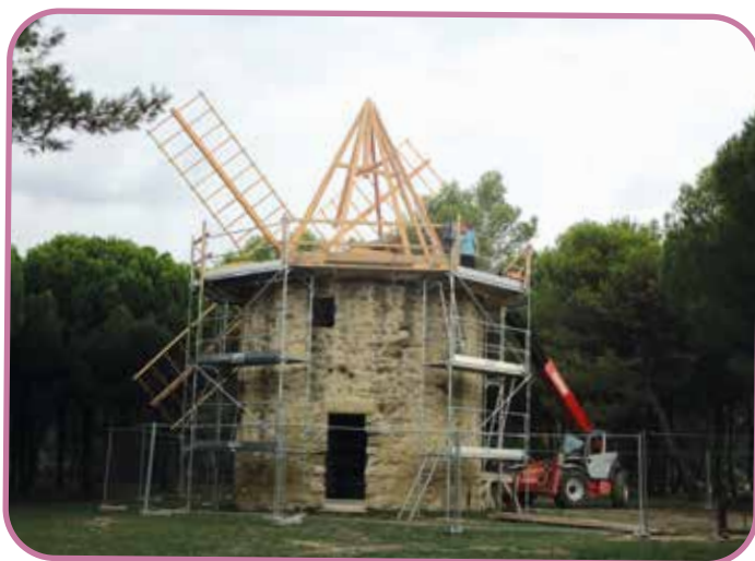
Les travaux du moulin
